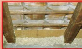
Dachschräge (mit Hinterlüftung)
