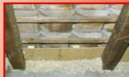
Dachschräge (mit Hinterlüftung)
