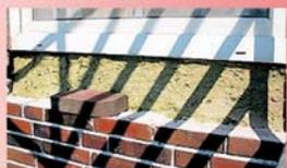
Hohlschicht mit Rockwool-Wärmedämmung
