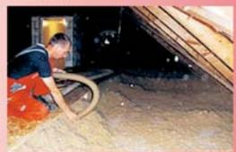
Dachbodenzwischenraum mit Rockwool-Einblastechnik
