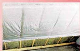
Schrägdach mit Rockfol PE Dampfsperre
